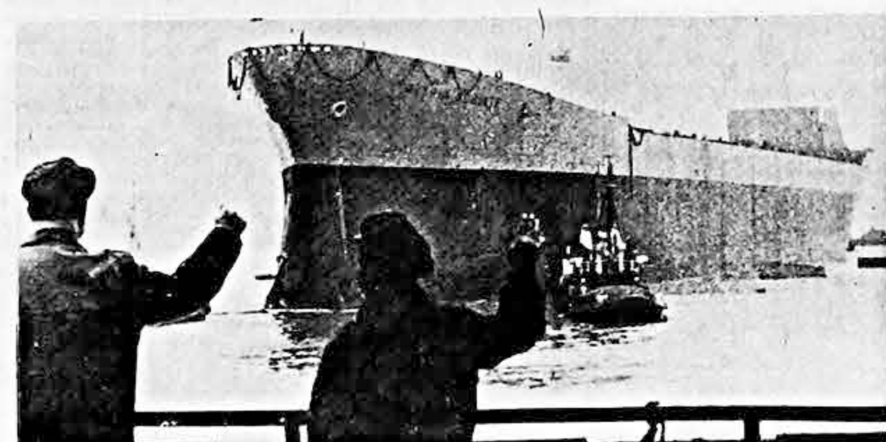
El "Ursula Schulte", el mayor barco de carga europeo, es lanzado en el Luebecker Pländerwerke. El barco de 80,000 toneladas tiene 233 metros de largo y 35 de ancho. En su construcción se emplearon 16,000 toneladas de acero (AP Wirephoto).
