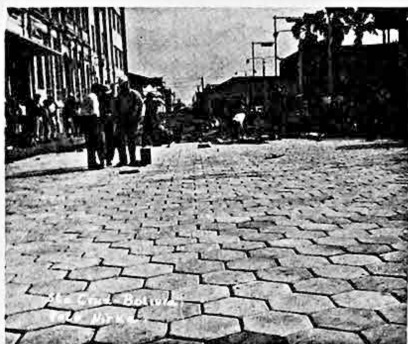
Las arenosas calles de la ciudad de Santa Cruz, por fin comienzan a ser pavimentadas. El gráfico muestra el trabajo de colocación de losetas en una de las calles de Santa Cruz.
