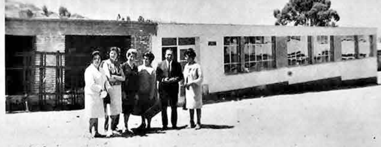
Este es el primer pabellón a medio construir de lo que será el futuro Hospital Broncopulmonar. Aparece un grupo de las Damas Voluntarias con cuyo esfuerzo se realiza esa obra. También está el Director del Hospital Dr. Néstor Cano del Castillo y la Sra. Bertha de Susz, quien entregó 10 ventanas metálicas a nombre de las damas israelitas.
