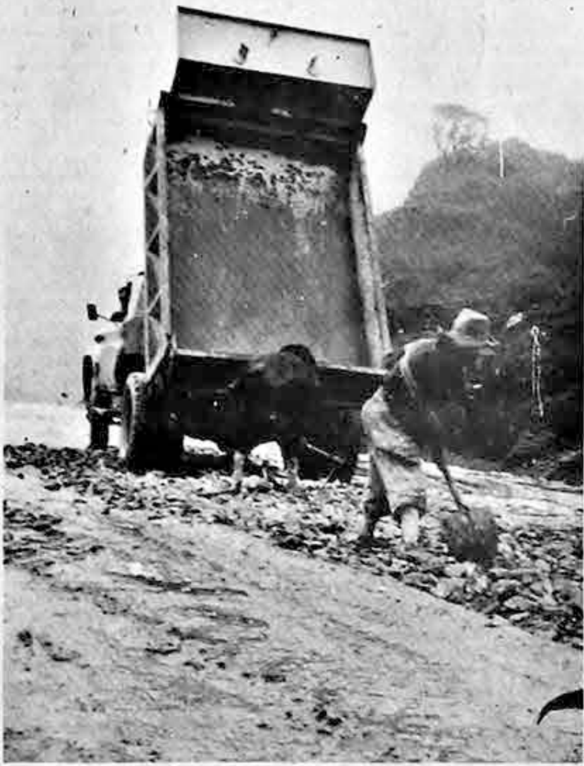
Otra cuadrilla del SNC echando ripio al camino Cochabamba-Santa Cruz, cuyo mantenimiento será incrementado durante las próximas semanas, con el crédito de cinco millones de dólares otorgados por USAID.B.
