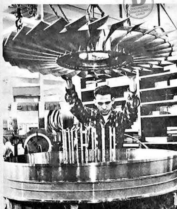
EL TITANIO USADO EN UN MOTOR DE PROPULSION A CHORRO - La pieza de este motor está hecha de titanio, el nuevo metal de la era del espacio, y va a ser instalada en el compresor de un motor a chorro Pratt y Whitney JT4. Las paletas producen un 30 por ciento más de fuerza motriz en los motores a chorro que la desarrollada por los de diseño corriente.
