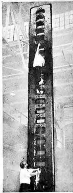
ESCALERA DE LA ERA ESPACIAL.- Ingenieros de la Goodyear prueban una escalera inflable, la cual será usada dentro de los tanques de combustible del cohete lunar Saturno V. Esta escalera se enrolla en un pequeño paquete para sumergirla a través de la abertura del tanque, la cual es suficientemente grande como para que entre un hombre, pero muy pequeña para introducir una escalera normal. Este diseño de goma mide alrededor de 8 metros de largo y es inflada dentro de los tanques.
